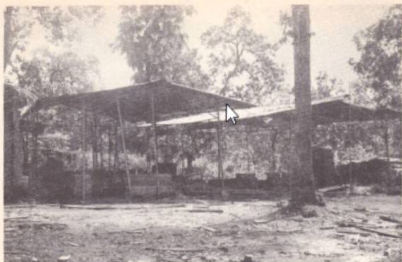
โรงเก็บไม้ของเครื่องเลื่อยเคลื่อนที่สามารถรื้อถอนและติดตั้งด้วยเวลาอันรวดเร็ว
